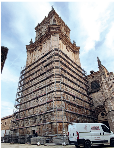
Colocación de los andamios
